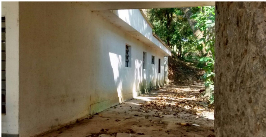
Figura 27. Parede externa da “Casa Branca” onde seria aplicada a proposta.
