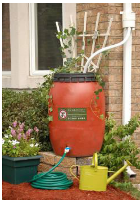
Figura 28. Exemplo de captação da água da chuva com armazenamento em barril.
