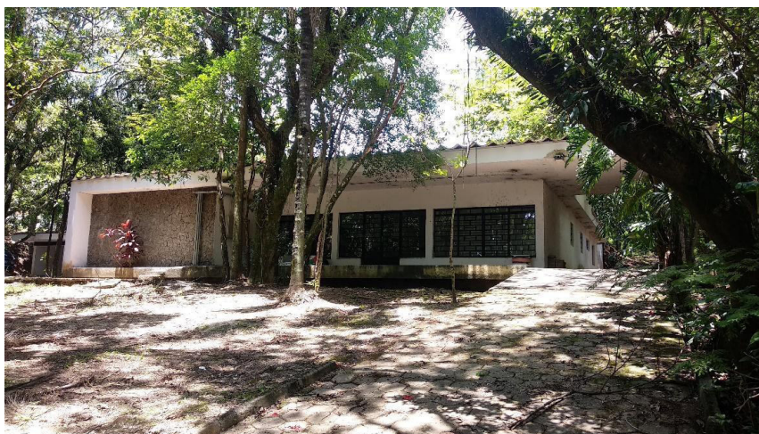
Figura 10. Foto frontal da casa no seu estado original atual.
